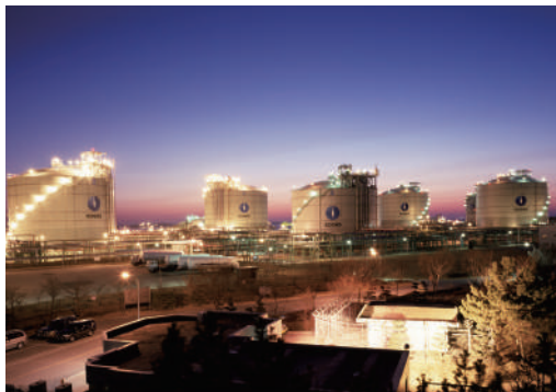
한국가스공사(KOGAS) 평택 LNG 터미널
